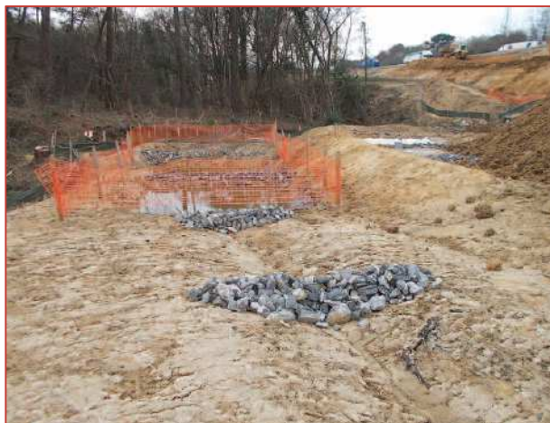
↑ Noue équipée de seuils en granulats concassés
